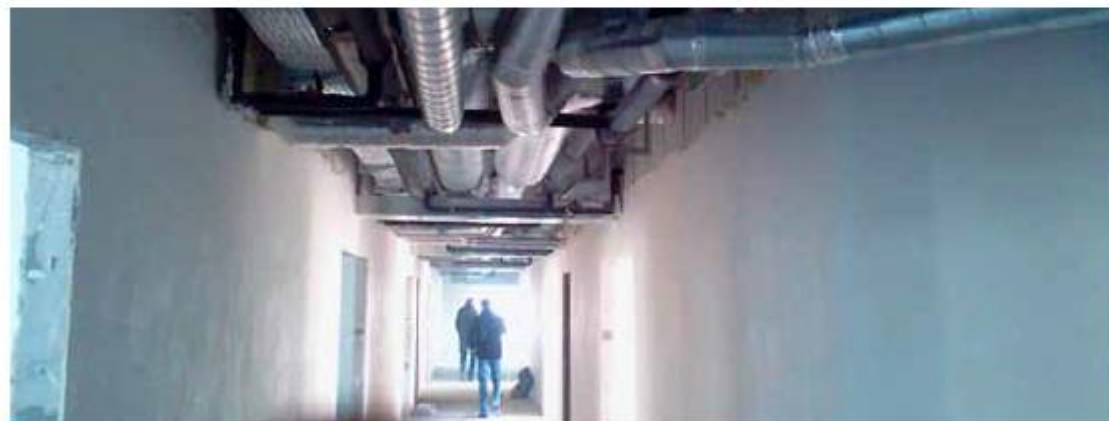
Процесс монтажа системы вентиляции и холодоснабжения
