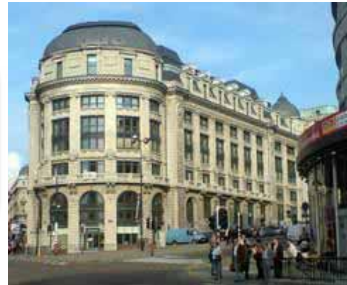
Integrator: RUF Gebäudetechnik Miltonberg, Germany
