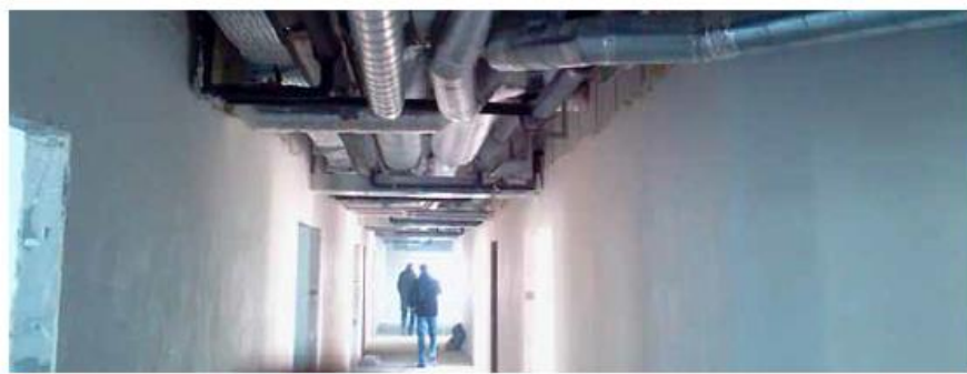
Процесс монтажа системы вентиляции и холодоснабжения
