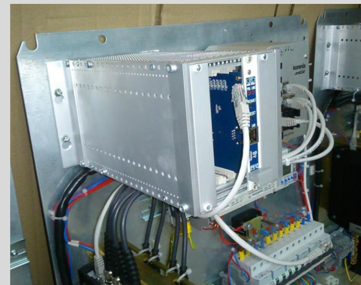
Монтажная панель (крепёжные фланцы сзади)
